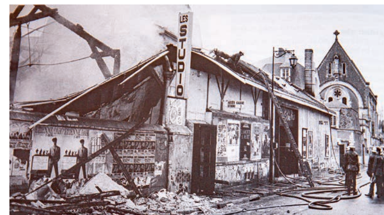
L'incendie de 1985 a ravagé plusieurs salles, entraînant de vastes travaux de réaménagement financés par un large mouvement de solidarité.
